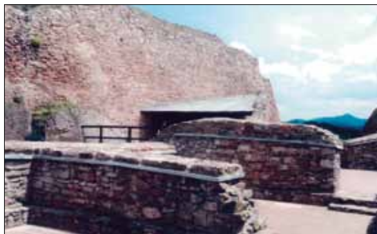
Mur tarczowy i tarasy widokowe na zamku górnym w Czorsztynie, stan współczesny
