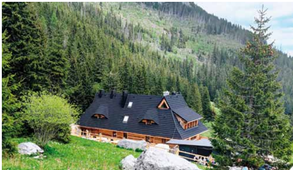
Nowe schronisko na Hali Kondratowej
